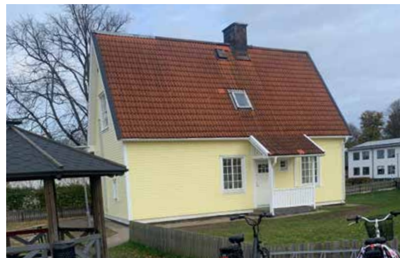
Mindre byggnad med kulturskola
