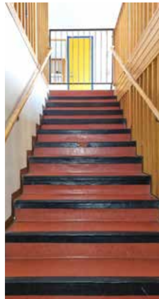
Trappa från källare
